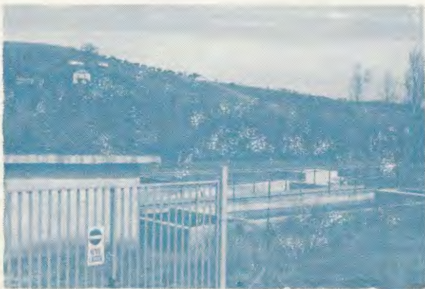
— Depuratore Centro Urbano
