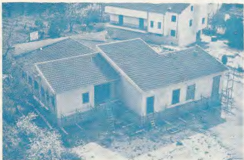
— Asilo Nido in via di ultimazione
